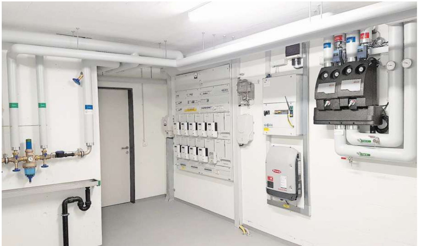
In der Überbauung Hintere Schilligmatte in Bürglen ist bereits eine integrierte Gesamtenergielösung im Einsatz. Mit Hilfe von Smart-Metern werden dort Wasser (links), Strom (Mitte) und Wärme (rechts) gemessen. Bild: PD
